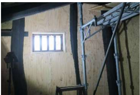
図5.(4)-7 なんと（北側） 工事
