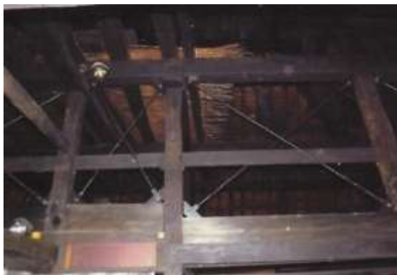
図5.(4)-21 なかでい（北側） 完成
