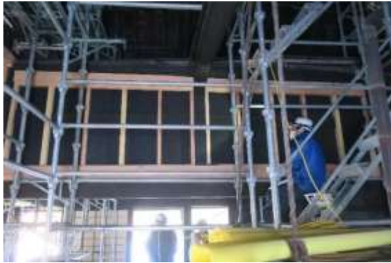
図5.(4)-13 でい (東側) 工事
