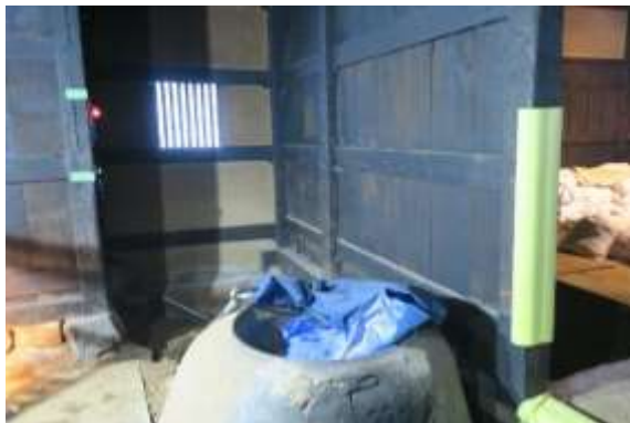
図5.(4)-15 にわ (東側) 工事
