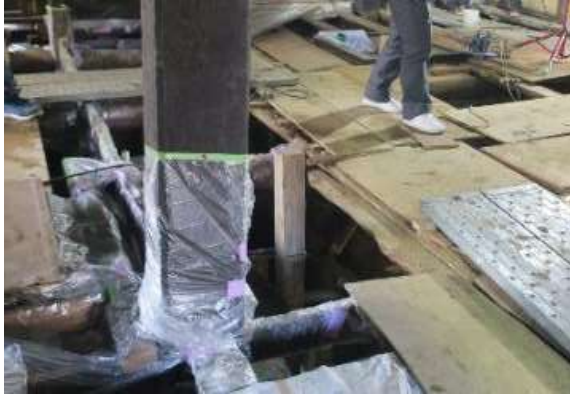
図5.(4)-9 おかみ (西側) 工事
