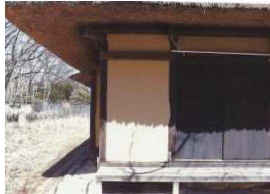
図5.(4)-18 外部（南側）おくざしき 完成
