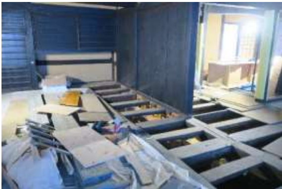
図5.(4)-11 おくざしき 工事
