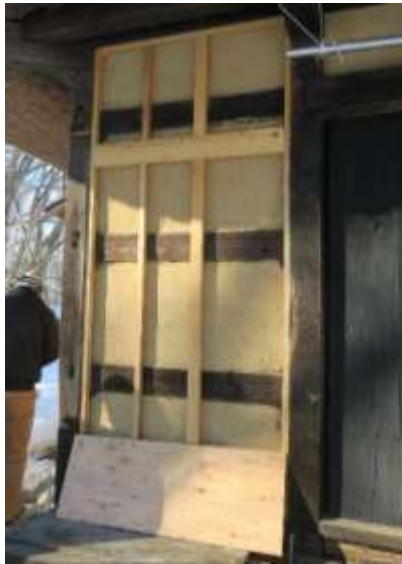
図5.(4)-17 外部（南側）おくざしき 工事
