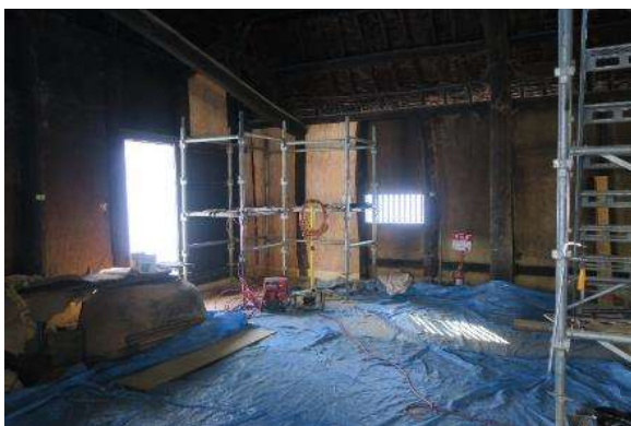
図5.(4)-3 にわ（西側） 工事
